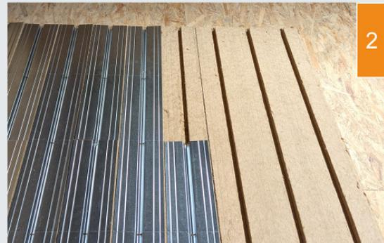
(2) Wärmeleitbleche werden in die Verlegeplatten eingelegt.
