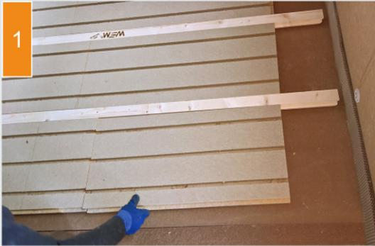
(1) Die Holzfaser-Verlegeplatten und Profileleisten werden ausgelegt.
