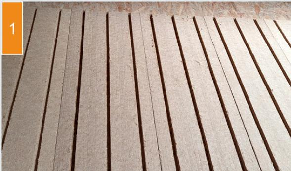
(1) Die Holzfaser-Verlegeplatten werden ausgelegt.
