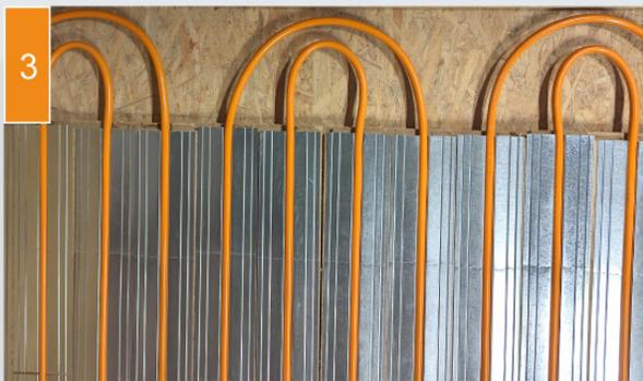
(3) Das Rohr wird verlegt und die Randbereiche mit Schüttung verfüllt.
