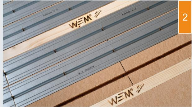
(2) Wärmeleitbleche werden in die Verlegeplatten eingelegt.
