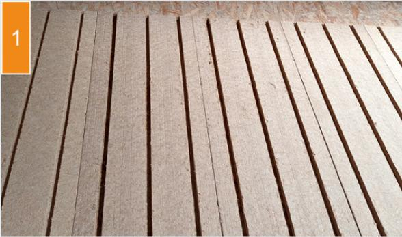
(1) Die Holzfaser-Verlegeplatten werden ausgelegt.
