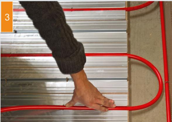
(3) Das Rohr wird verlegt und die Randbereiche mit Schüttung verfüllt.
